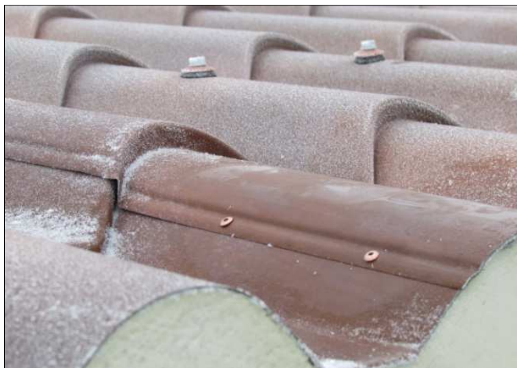
Exemple d'utilisation correcte des rivets
